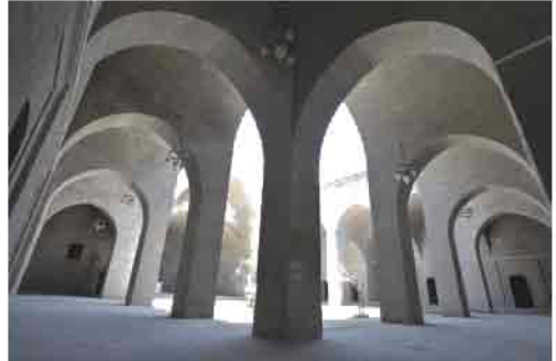
Şifahane'de avlu etrafında yer alan revak sistemi
